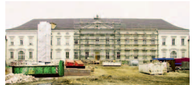
Schloss Bellevue während der Restaurierungsarbeiten 2004/2005
